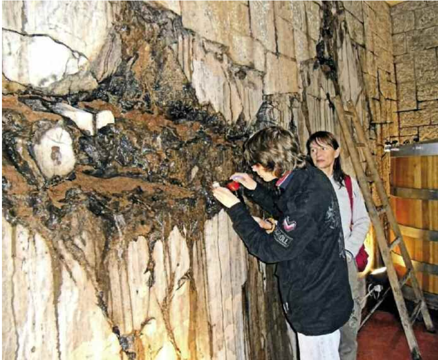
Fig. 2: Particolare di una parete della cantina dove avviene una fuoriuscita di sostanza gelatinosa.
